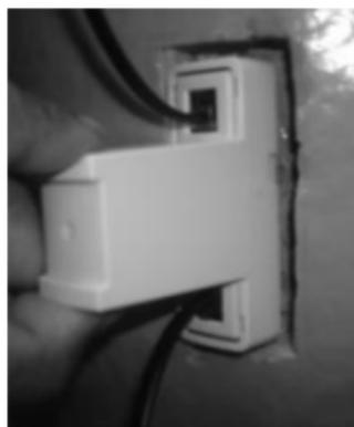
A questo punto riempire eventuali vuoti utilizzando dell'adesivo e l'isolamento precedentemente rimosso. Utilizzare una corda tirabile per assicurare il sensore al serbatoio così da completare l'installazione.
